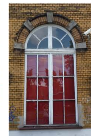
Fot. 11 - Istniejące okno
