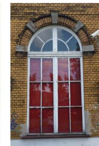
Fot. 11 - Istniejące okno
