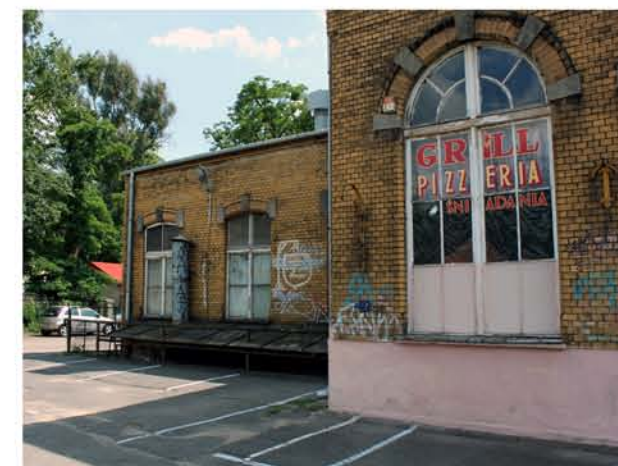
Fot. 10 - Skrzydło wschodnie - widok od strony peronu
