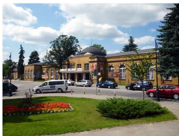
Fot. 5 - Widok dworca od ul. Kopernika
