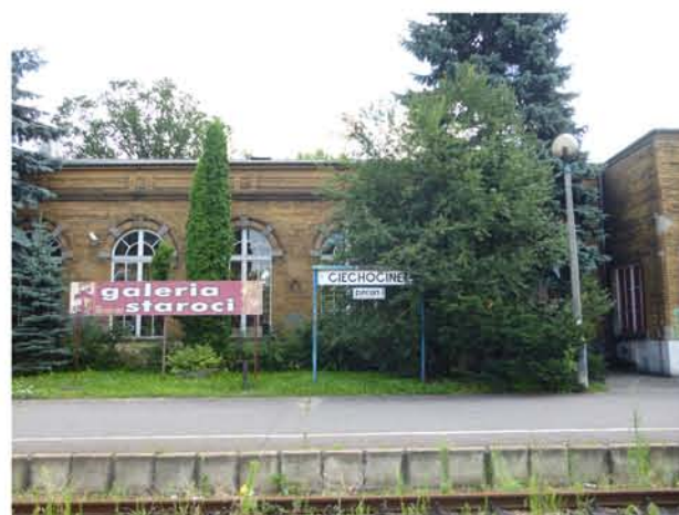
Fot. 9 - Widok dworca od strony peronu
