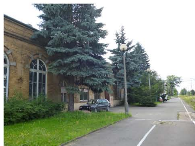
Fot. 8 - Widok dworca od strony peronu
