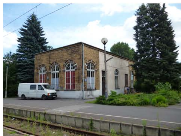
Fot. 4 - Skrzydło zachodnie, widok od strony torów kolejowych
