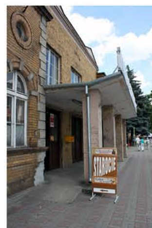
Fot. 6 - Wejście główne
