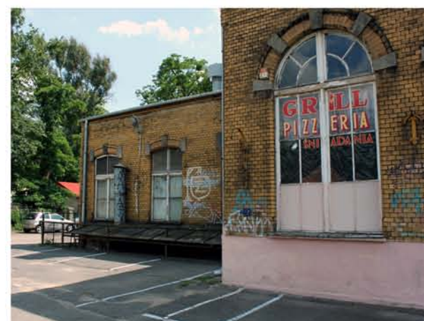
Fot. 10 - Skrzydło wschodnie - widok od strony peronu
